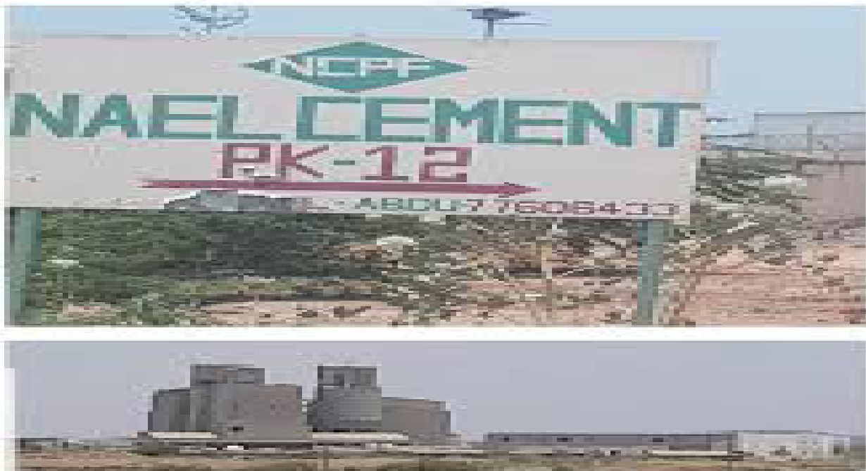
Cimenterie dénommée Nael Cement du PK12
