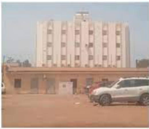
Sur l'immeuble Heego du Plateau du Serpent, à Djibouti-ville
